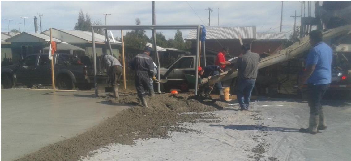
Ubicada en la áreas de equipamiento del loteo Los Copihues de Cherquenco, se dio inicio a las obras de construcción de tan anhelada multicancha, la cual consta de una losa de hormigón, pintada, arcos de baby futbol y básquetbol, incorporando un cierre perimetral de altura e iluminación.
