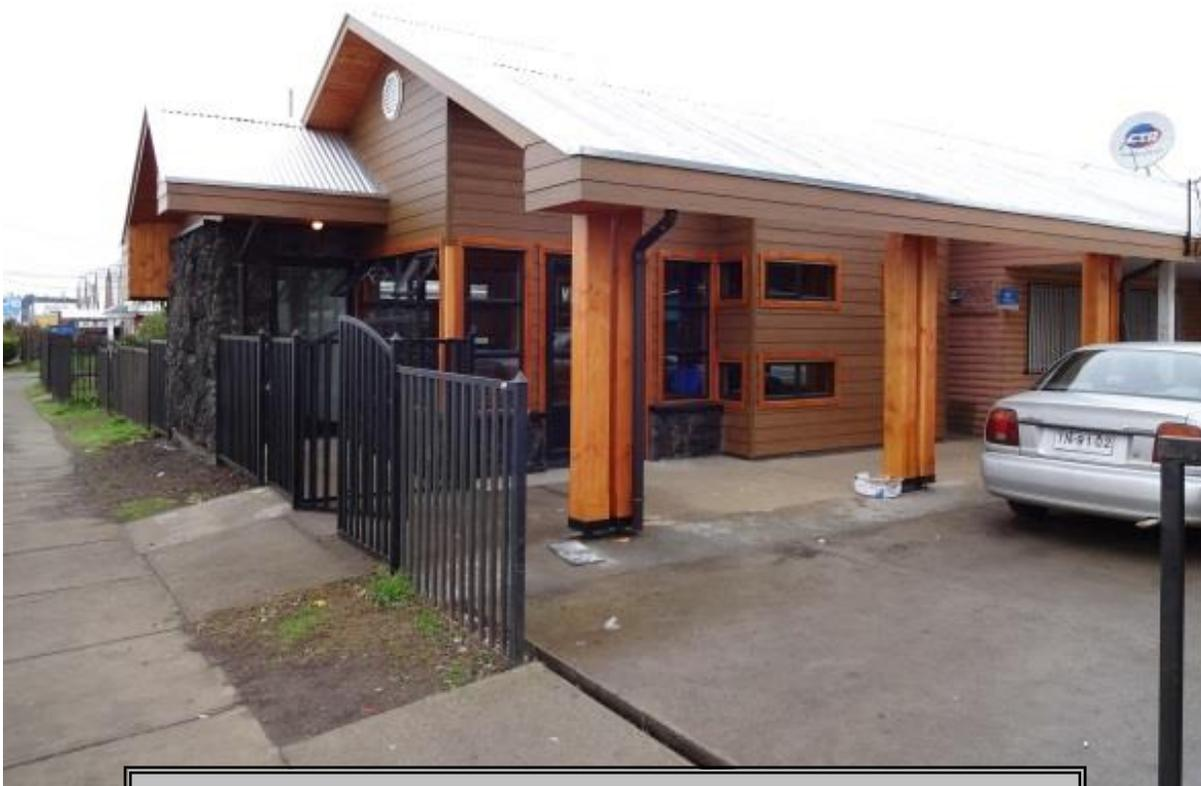
Construcción de 54 m<sup>2</sup> sobre radier y estructura de madera, cuenta con una terminación de piedra para un diseño corporativo e identidad volcánica
