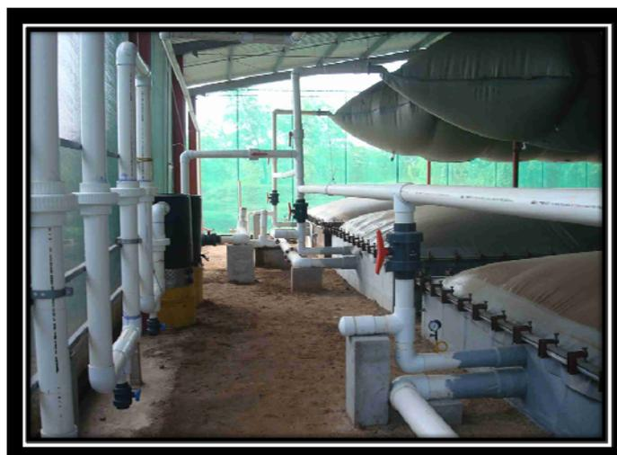
Modelo de biodigestor industrial utilizado en la Universidad EARTH de Costa Rica
